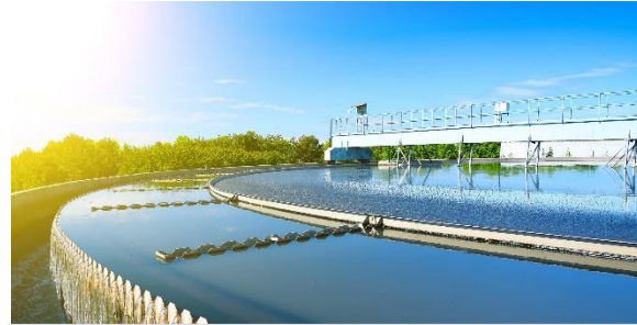
Tratamiento de agua
