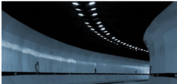
Ventilación del túnel
